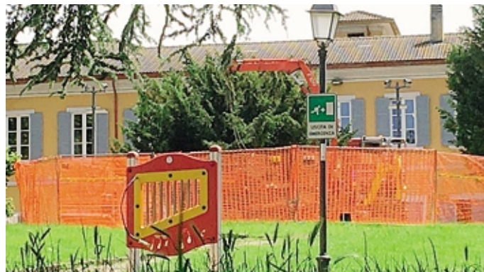
Il parco di via Roma chiuso con l'escavatore al lavoro
